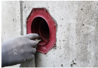
1. Sicke reinigen.
