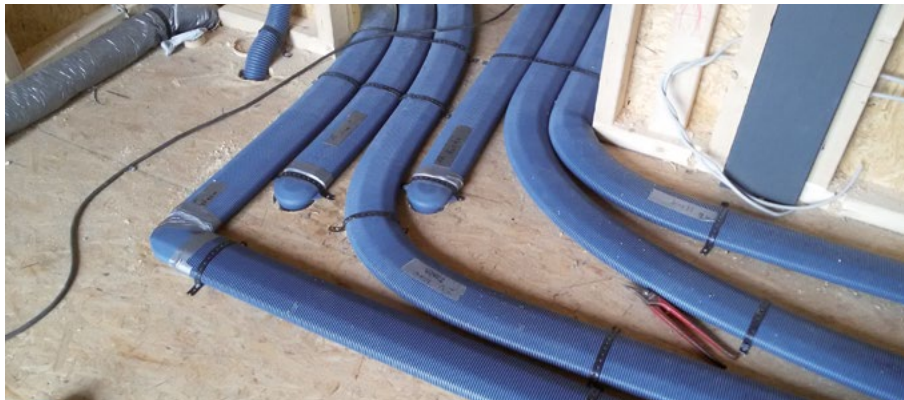
Verbindungsstellen mit Kaltschrumpfband abkleben
