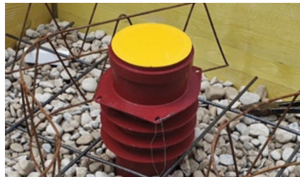
Einrichten auf Oberkante Fundamentplatte
