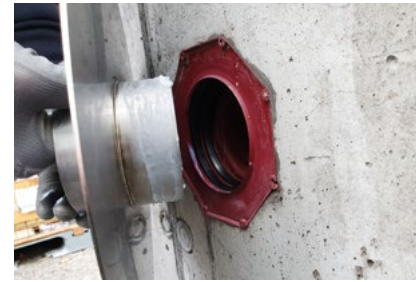
3. Einsteckende mit Gleitmittel bestreichen und bis zum Anschlag einschieben.
