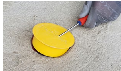
Bauschutzdeckel entfernen
