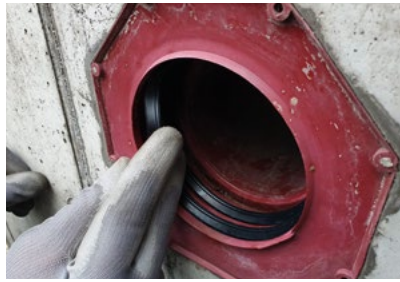
2. Lippendichtringe einsetzen.
