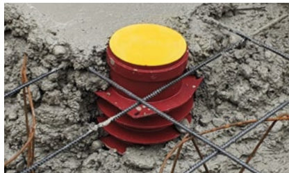
Betonieren und rütteln
